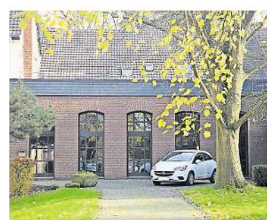
Wegen eines „Lecks“ im Flachdach nicht zu nutzen: Der Anbau des Linnicher Rathauses. FOTO: JONEL
